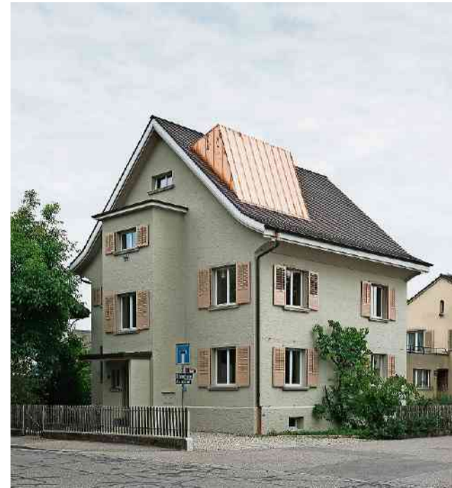
Von aussen (fast) unverändert: Die kupfrig glänzende Lukarne verweist auf den Umbau.
