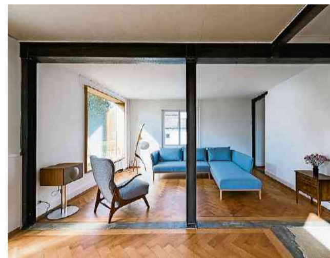
Wand weg: Rohe, gewalzte Stahlträger und -stützen tragen die Last.
