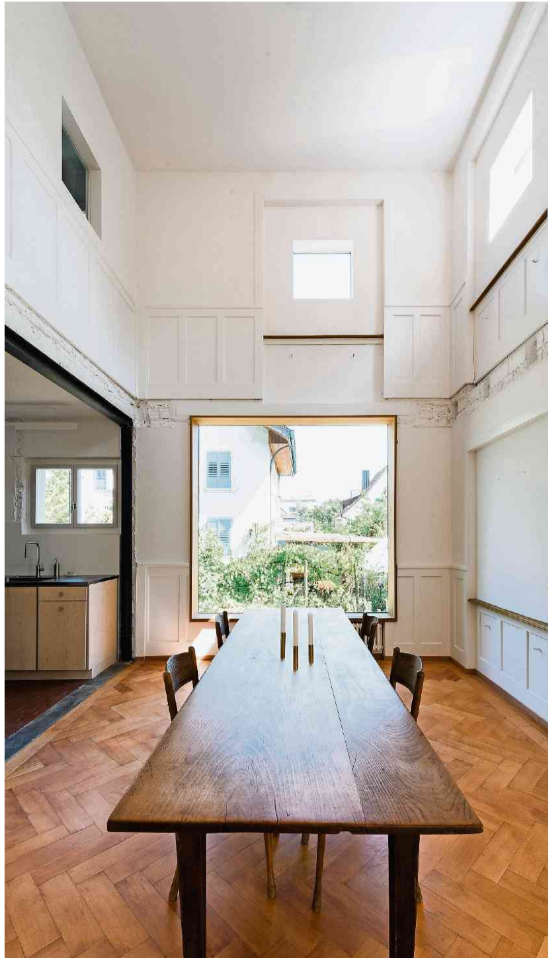
Weit geöffnet: Über dem Esszimmer wurde die Decke entfernt – die Spuren der Veränderung bleiben erhalten. ALLE BILDER: N. BECHTEL/WÜLSERBECHTELARCHITEKTEN
