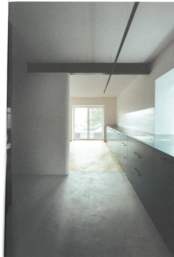
Ein neuer Doppel-T-Träger aus Stahl deutet an, dass eine Wand entfernt wurde.
