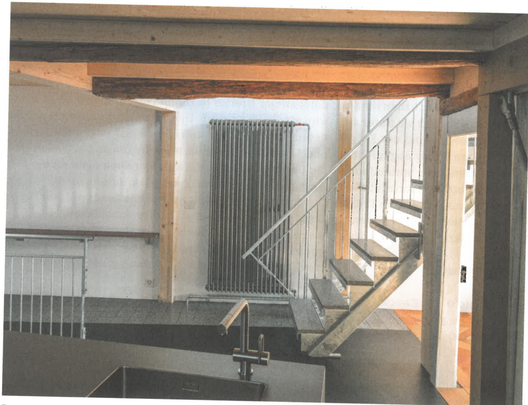
Farblich zurückhaltende Oberflächen und Einbauten prägen die Aneignung des Bestands. Die Konstruktion ist maximal direkt, die Leitungen sind offen geführt.
