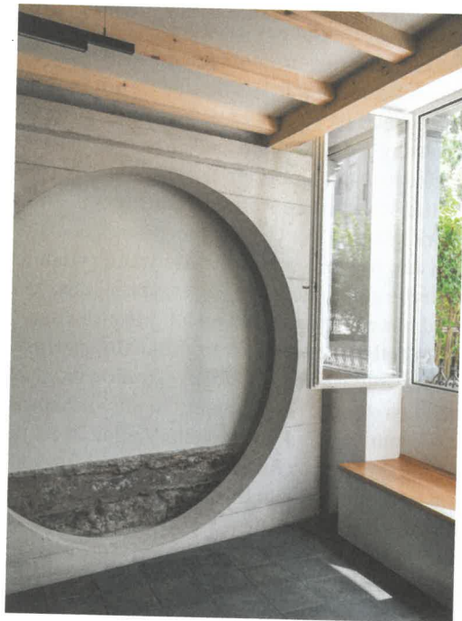
Wo eine Brandwand entfernt wurde, stabilisiert nun ein betonierter Vierendeelträger das Ensemble.
