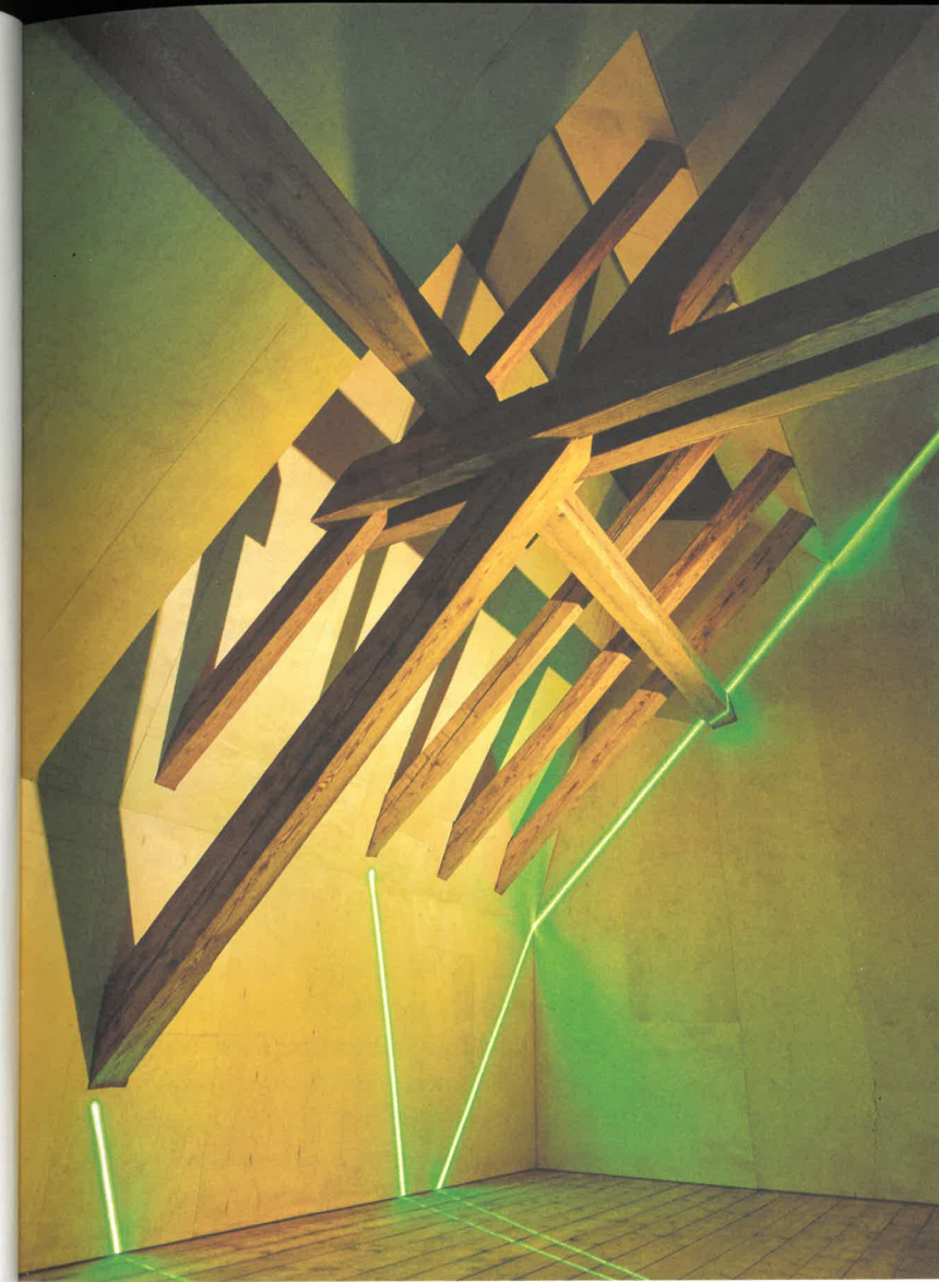
Oben und rechts Eine Lukarne bringt Zenitallicht in das Dachgeschoss.
