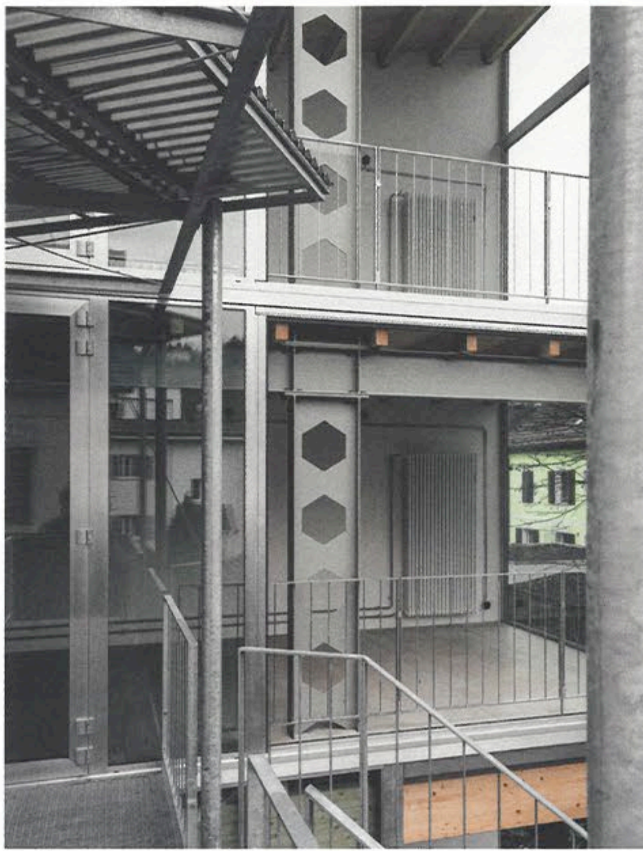
Pro Geschoss balancieren unterschiedliche Balken auf dem Wabenträger.
